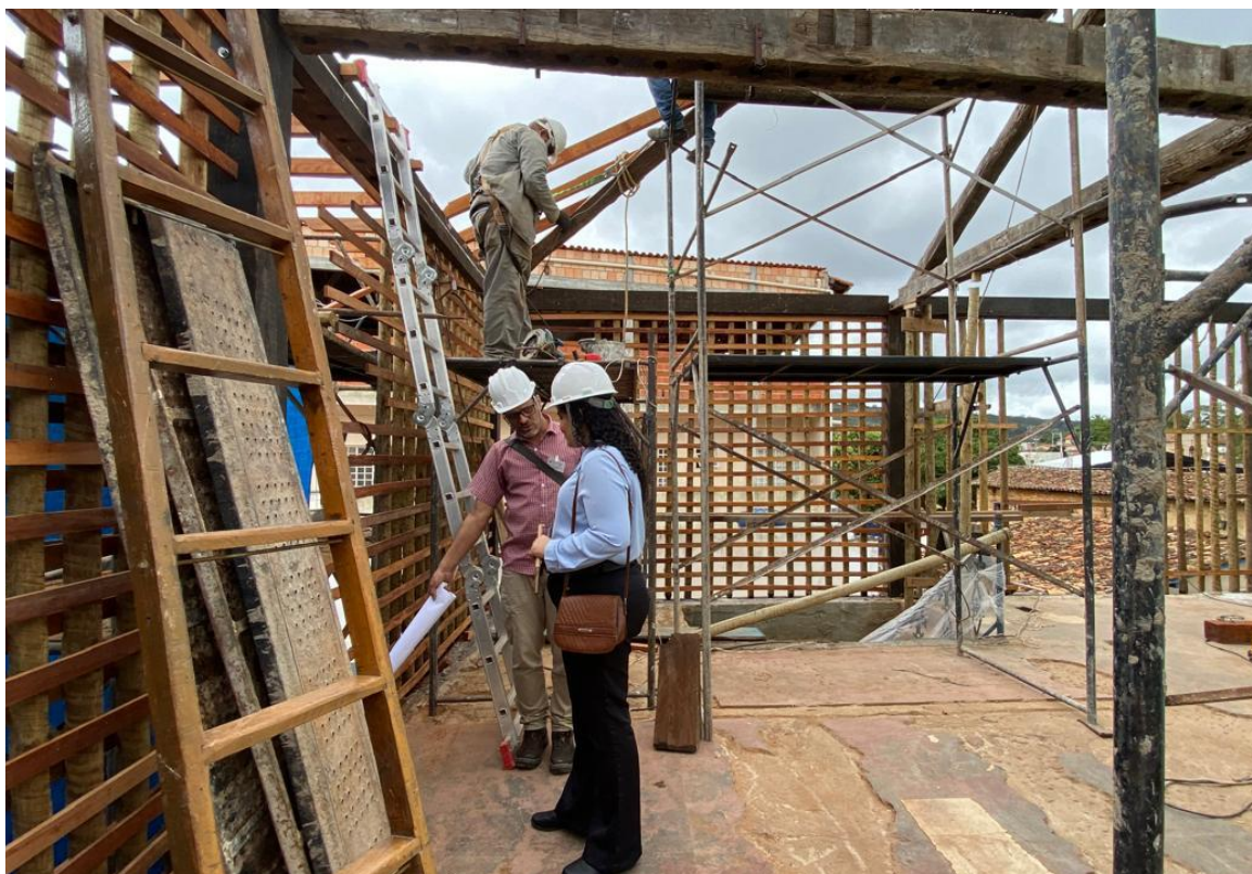
Acompanhamento dos serviços de reforço estrutural e refazimento das alvenarias de pau-a-pique Autoria: Joaquim Artes e Ofício Data: 08/05/2025
