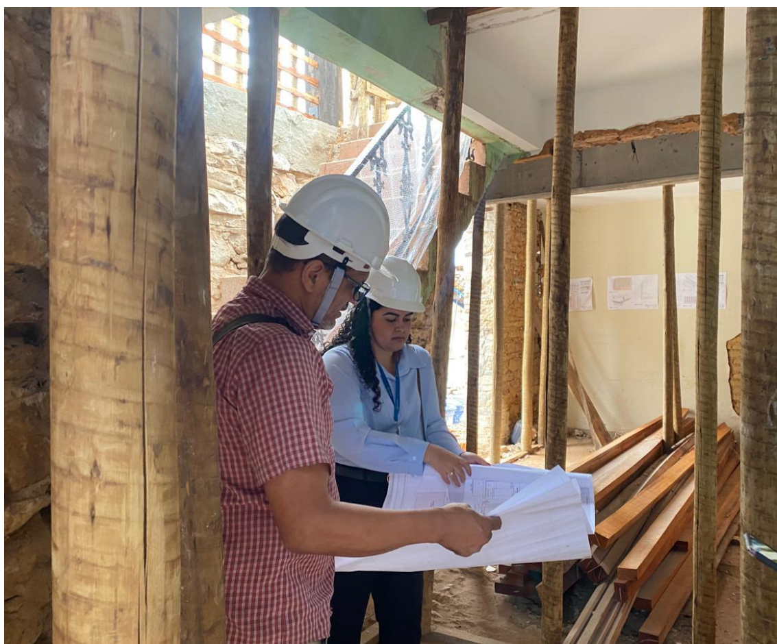
Acompanhamento da execução dos serviços previstos nos projetos aprovados Autoria: Francielle Ferreira Data: 08/05/2025
