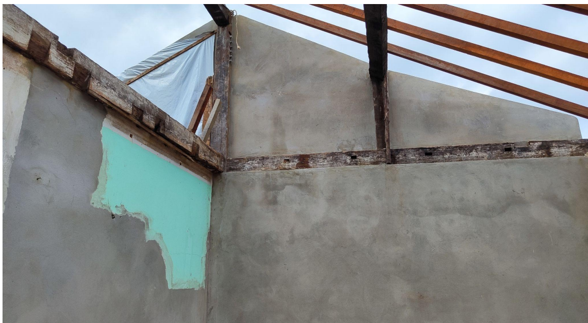
Execução dos serviços de reboco Autoria: Francielle Ferreira Data: 08/05/2025
