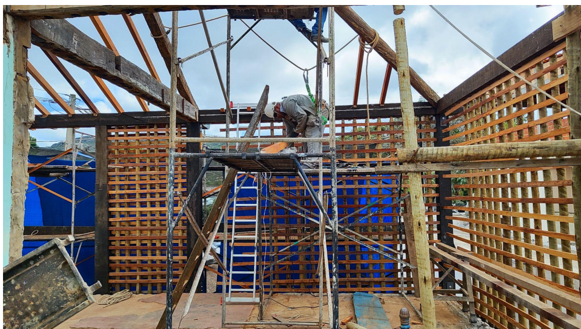
Execução dos serviços de intervenção estrutural nas alvenarias de pau-a-pique Autoria: Francielle Ferreira Data: 08/05/2025
