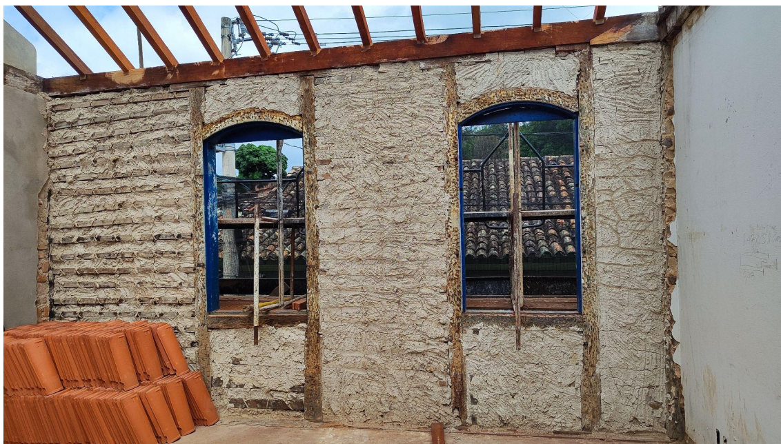
Execução dos serviços de vedação e reboco Autoria: Francielle Ferreira Data: 08/05/2025
