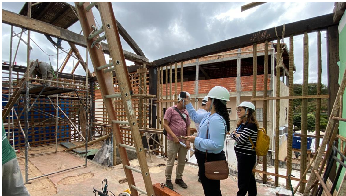
Acompanhamento dos serviços de reforço estrutural e refazimento das alvenarias de pau-a-pique Autoria: Francielle Ferreira Data: 08/05/2025
