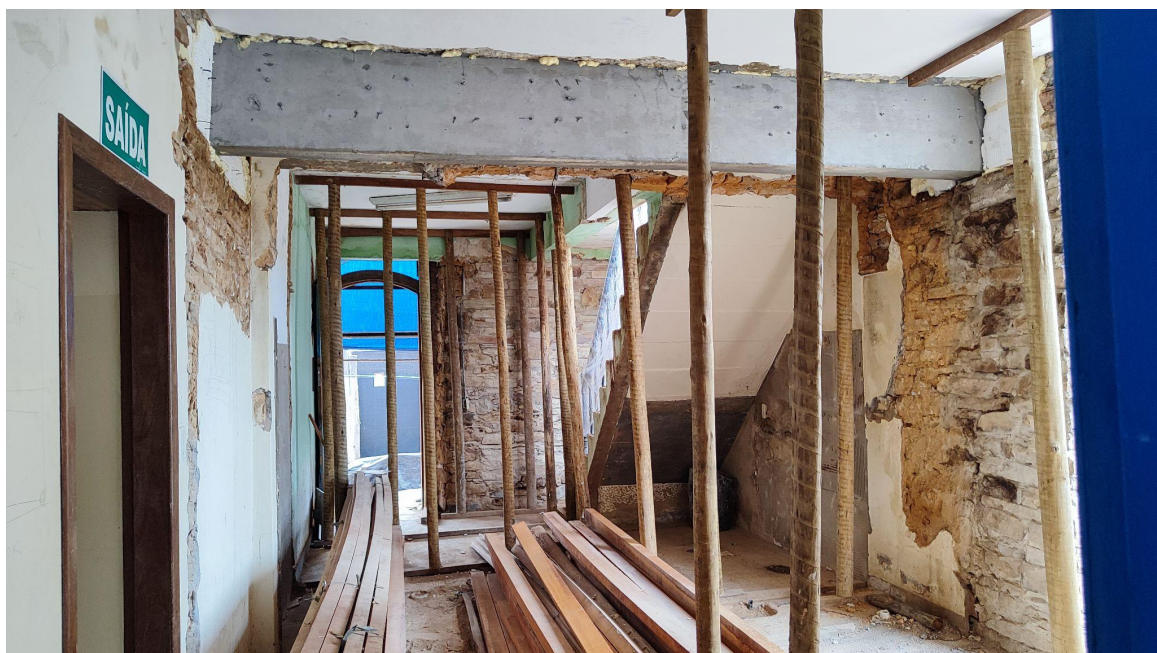
Execução dos serviços de intervenção estrutural Autoria: Francielle Ferreira Data: 08/05/2025
